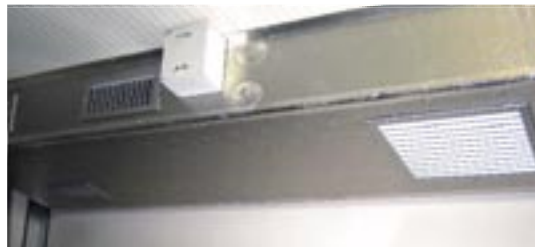
Impianto di climatizzazione con diffusione canalizzata
