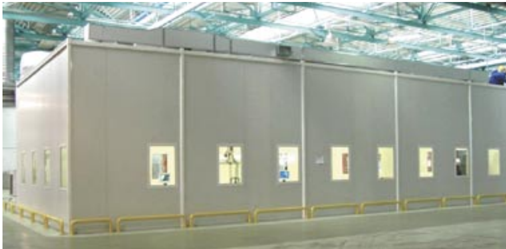
Sala metrologica installata su linea di montaggio motori auto
